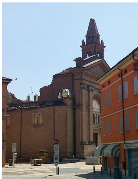
Figura 1. Danni causati dal terremoto nel comune di Cavezzo.
