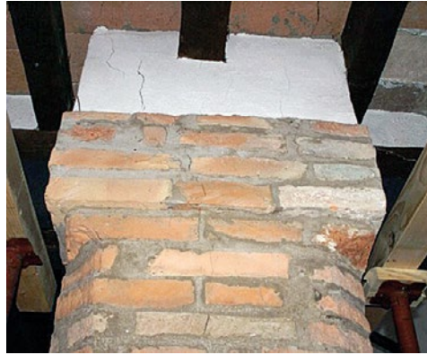
Figura 2. A sinistra è riportata una pianta schematica della “Sala delle colonne”, ove sono stati evidenziati in rosso i capitelli danneggiati durante il sisma del 2012. Sulla destra, a titolo di esempio, è rappresentato uno dei capitelli danneggiati, in cui risultano evidenti le lesioni verticali causate dalle oscillazioni della struttura.
