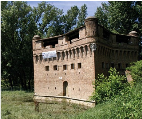
Figura 3. Vista della Rocca possente di Stellata durante i lavori di messa in sicurezza nel 2013.
