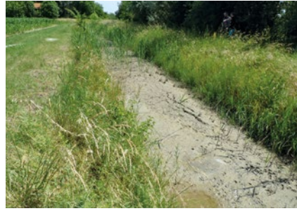
Figura 5. A sinistra, sabbia fuoriuscita da un pozzo per acqua presso lo stadio di San Felice sul Panaro (Modena). Notare, oltre la rete metallica, alcune tende di terremotati. A destra, emersione con rigonfiamento e fratturazione del fondale di un canale presso San Martino Spino (Mirandola, Modena). Entrambi gli effetti sono stati indotti dal sisma del 20 maggio 2012.
